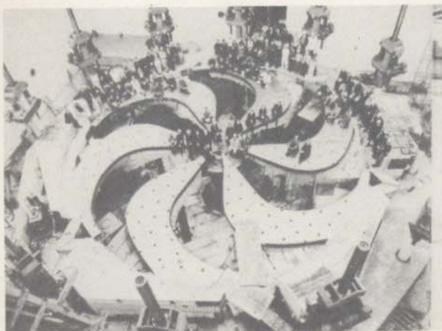
Metade inferior do ímã de um ciclotron moderno em construção, em 1972. A equipe dos construtores aparece na foto e dá uma idéia de suas dimensões.
